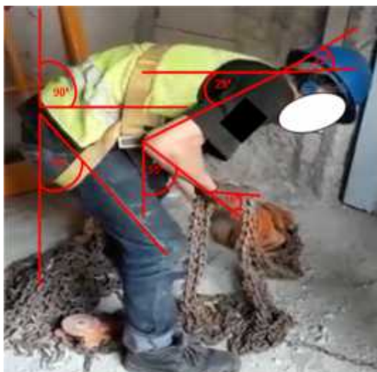
Gambar 1. Posisi Aktivitas Drop Material/ Manual Material Handling (Merapihkan Rantai Chainblock Yang Terlilit dan Akan Diangkat Kedalam Shaft Lift)
